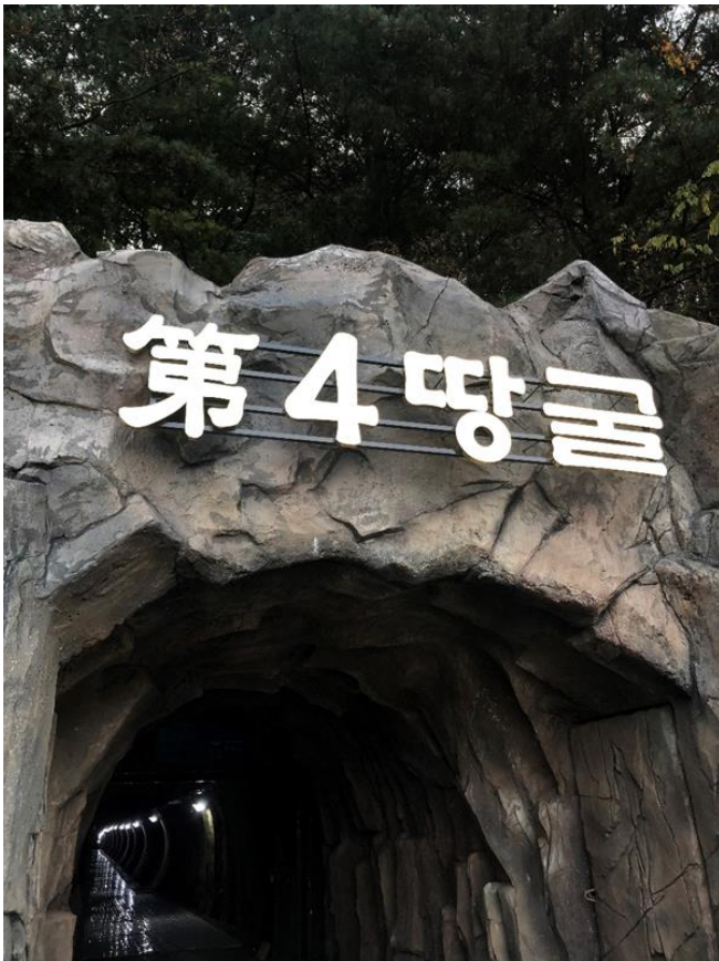
(第4トンネル入り口)
